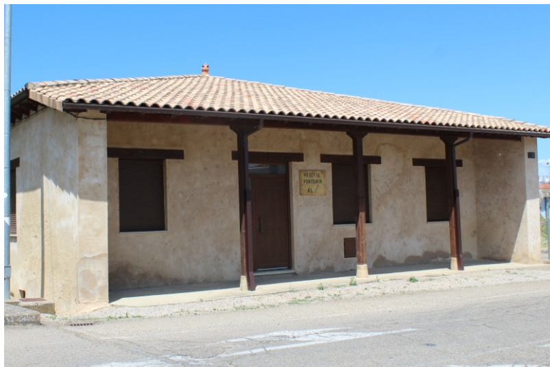
Edificio de la venta de Fuenteencalada, hoy cuidadosamente restaurado
